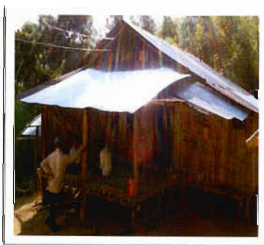
ภาพ 12 บ้านพักลุงชายที่ปลูกในพื้นที่เจ้าของที่ดินคนไทยในตำบลโป่งแยง อำเภอแม่ริมที่ได้รับอนุญาตให้ปลูกสร้างและทำสวนดอกไม้ได้แต่ให้ลุงชายทำหน้าที่เป็นผู้ดูแลสวนด้วย
